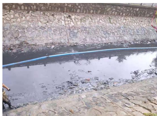
清安河正在开展清淤工程
