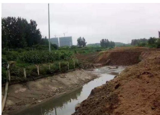
小南河正在开展清淤工程
