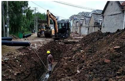
文渠正在开展清淤工程
