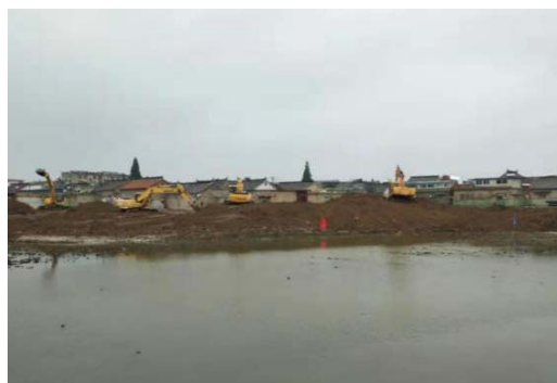
西汪塘地形整理施工
