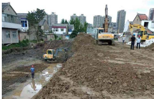
老涧河关天培路北基础施工
