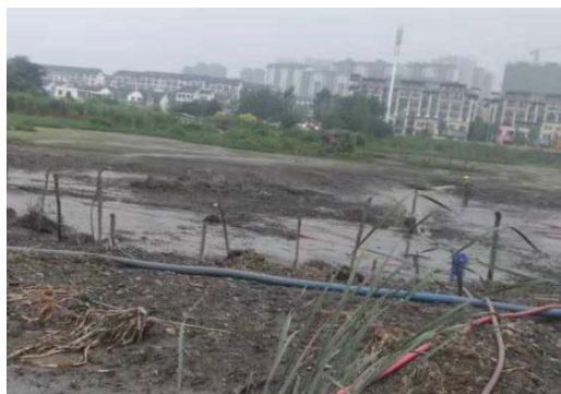
荷湖开展清淤工程
