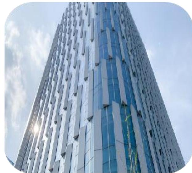
栋楼的特点，异形单元板块及单元板块重量，运用 BIM 分别对每栋楼进行建模给出吊装方案；将转角处的两个板块优化为一个超大异形板块，解决一大一小两个板块转角拼装难问题，同时提高了转角整体性和美观度。
