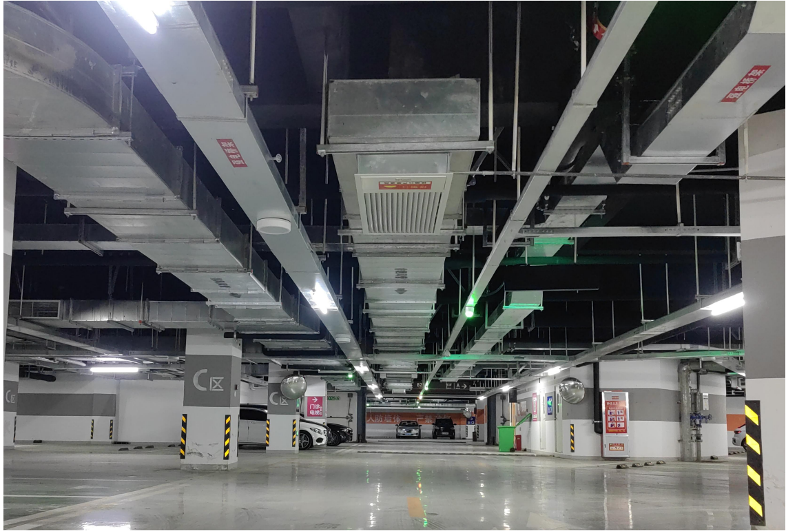
12、地下车库综合管线排布合理，采用成品综合支吊架，安装整齐美观
