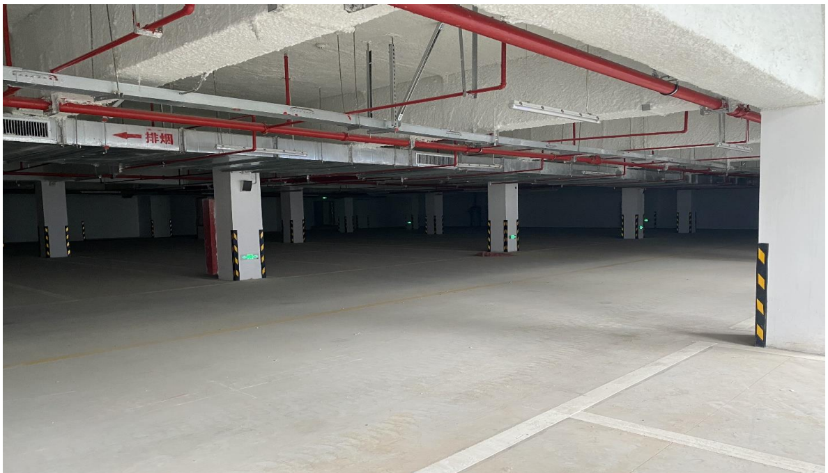
地下室顶板喷涂玻璃纤维保温
