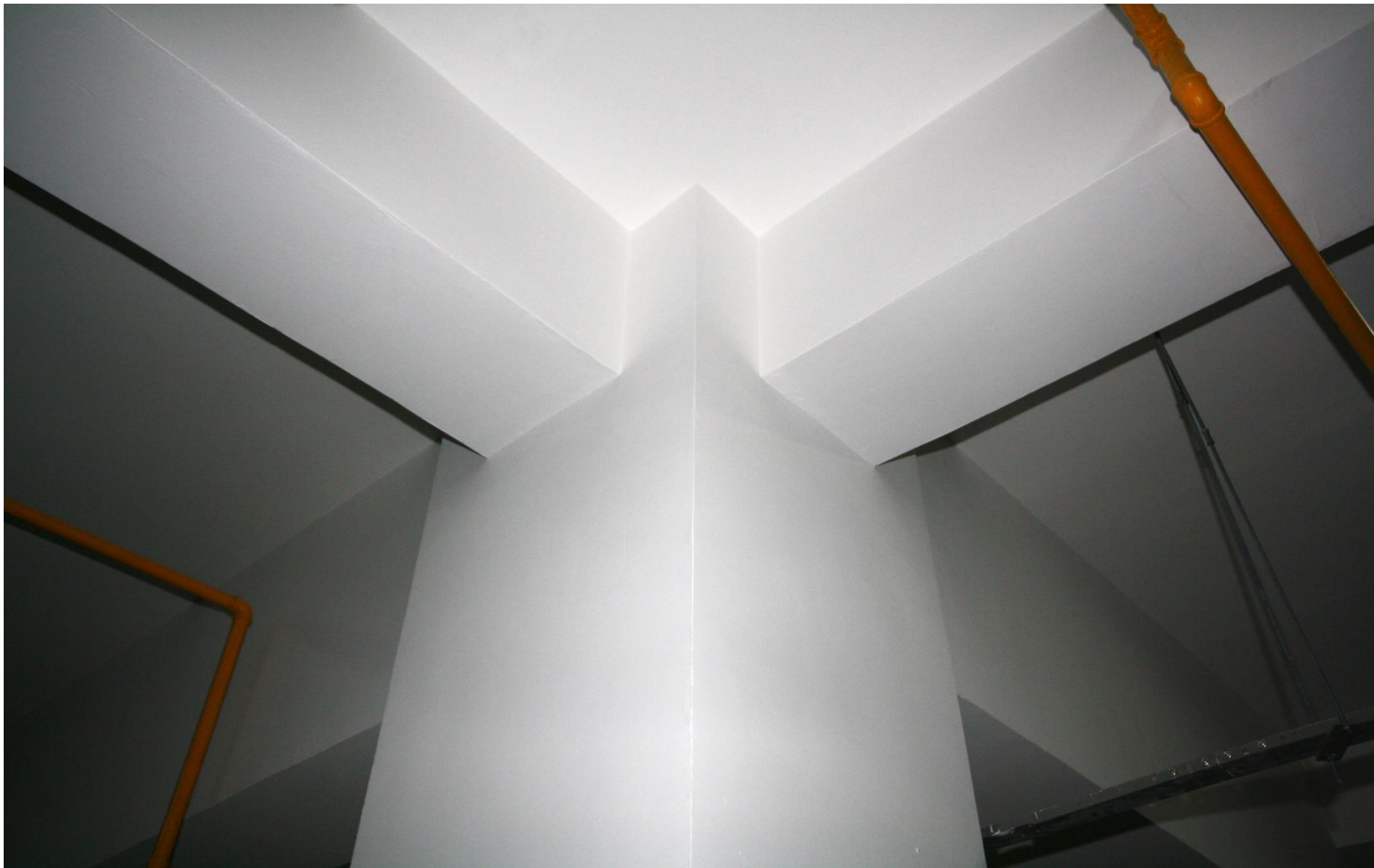
柱梁板抹灰阴阳角方正、顺直，涂料饰面颜色均匀一致。
