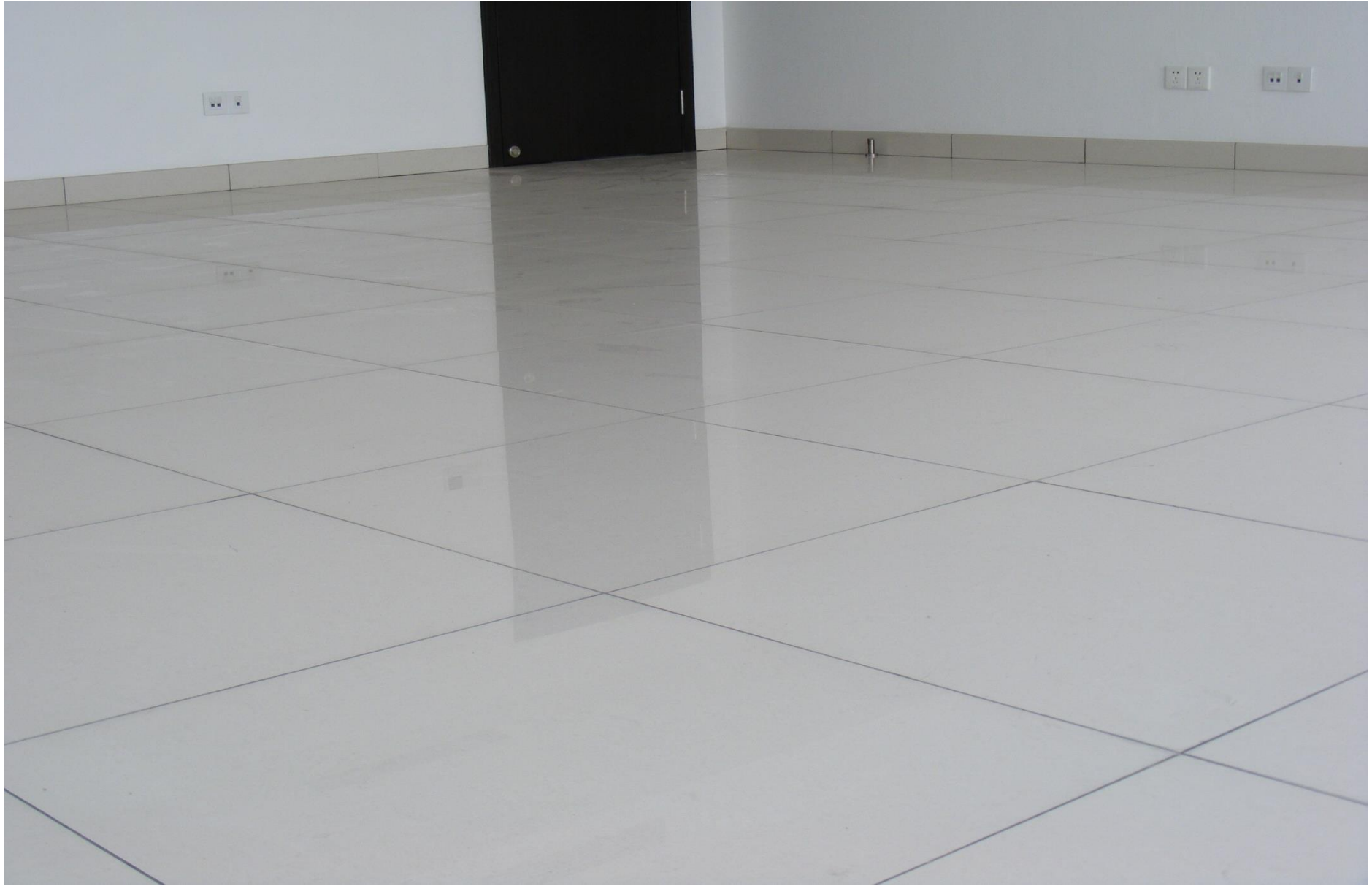
室内地砖楼地面镶贴平整、缝格顺直，墙面、踢脚线与地面缝格对线。
