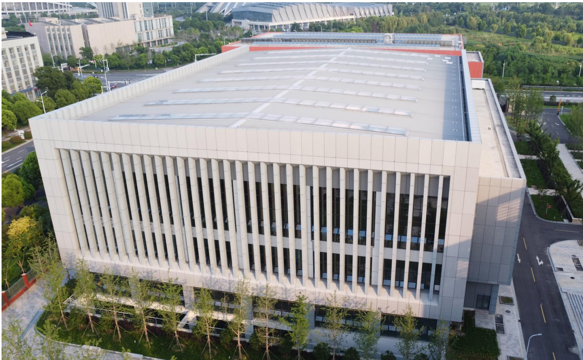
北立面灰色铝通格栅幕墙、钢桁架结构不上人屋面及玻璃采光顶。
