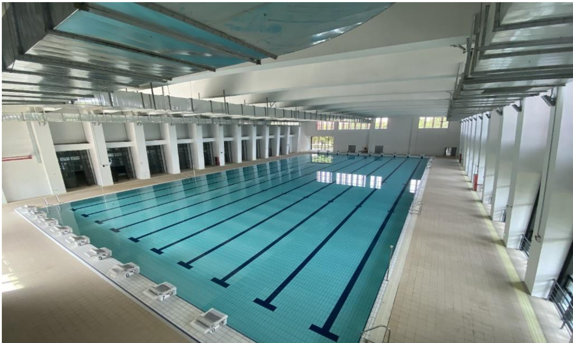
游泳馆屋面梁为跨度超 36m 变截面有粘结后张法预应力梁。泳池内外地砖镶贴平整、缝格顺直、阴阳角方正、套割精细。
