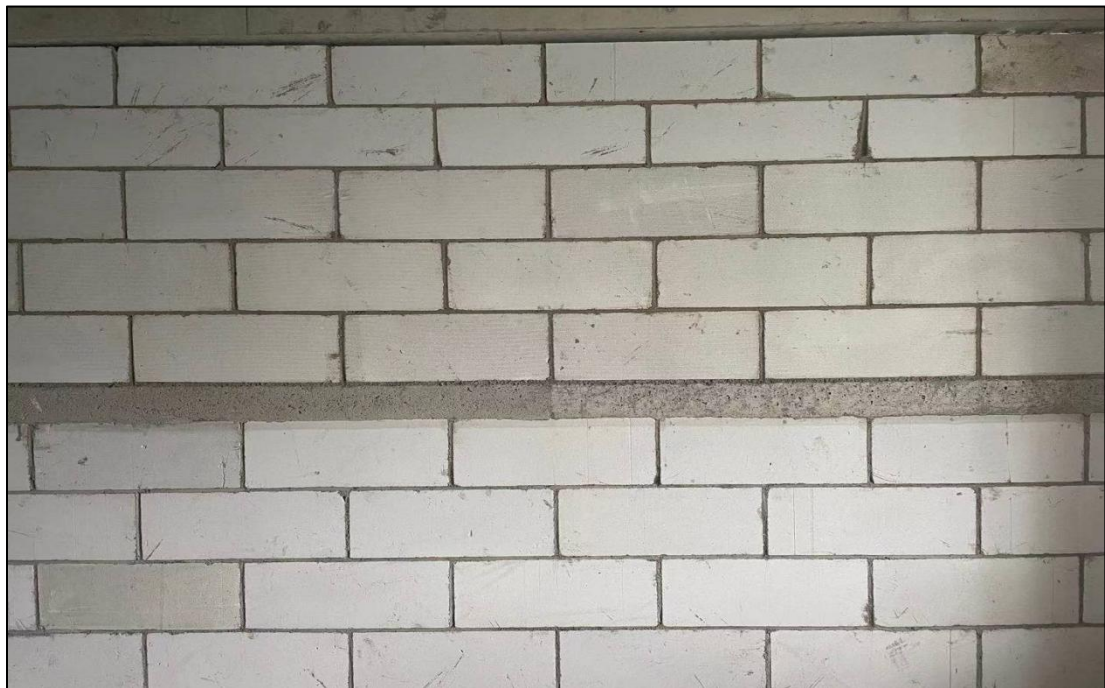
图 19：室内二次结构砌体
