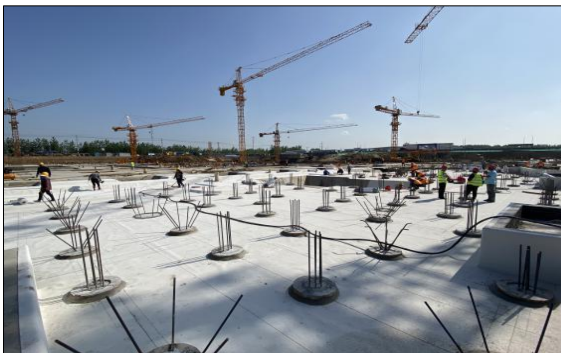
图 10：底板预铺反粘防水
