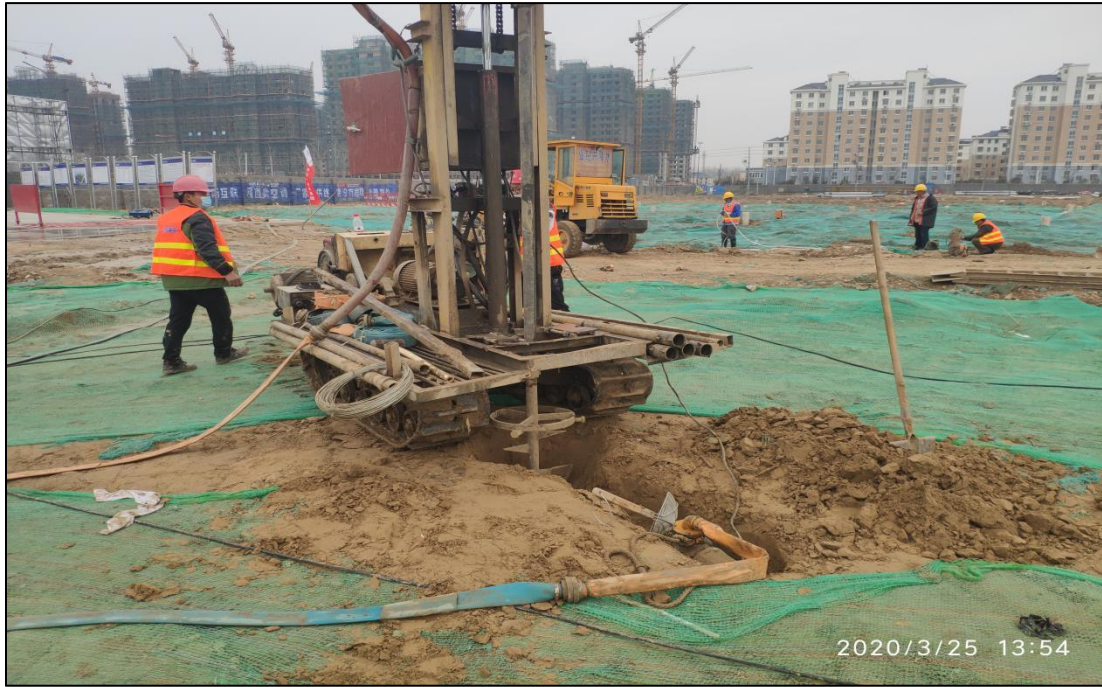
图 7：降水井施工
