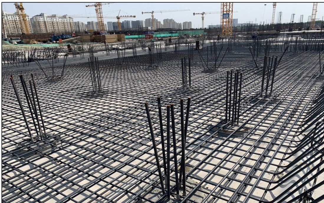
图 12：地下室筏板钢筋绑扎
