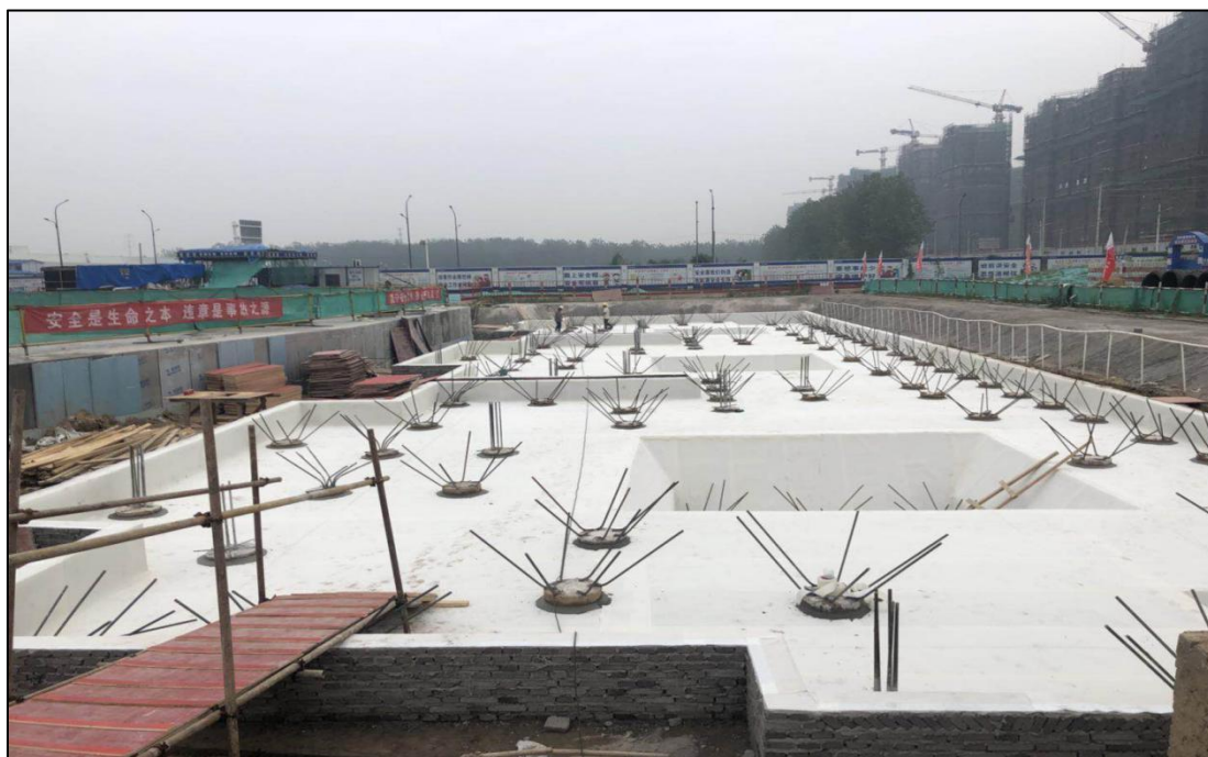
图 9：底板预铺反粘防水
