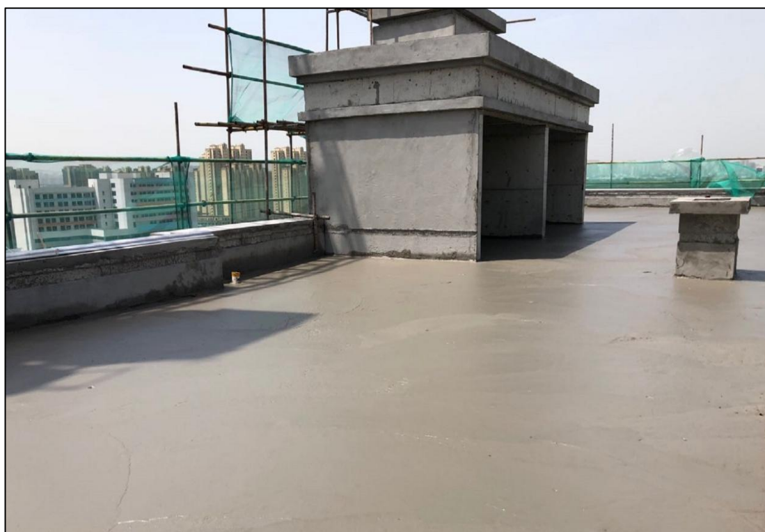
图 26：屋面泡沫混凝土施工
