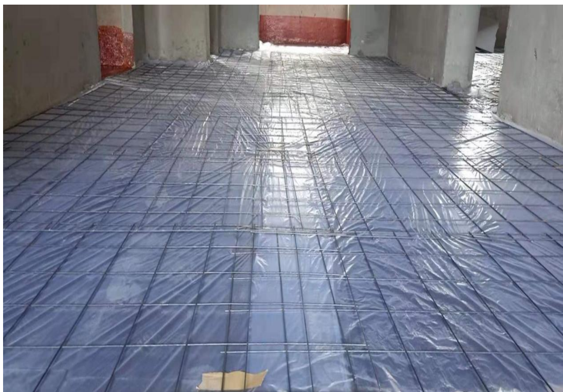
图 31：隔音楼板隔声板及 PE 膜覆盖
