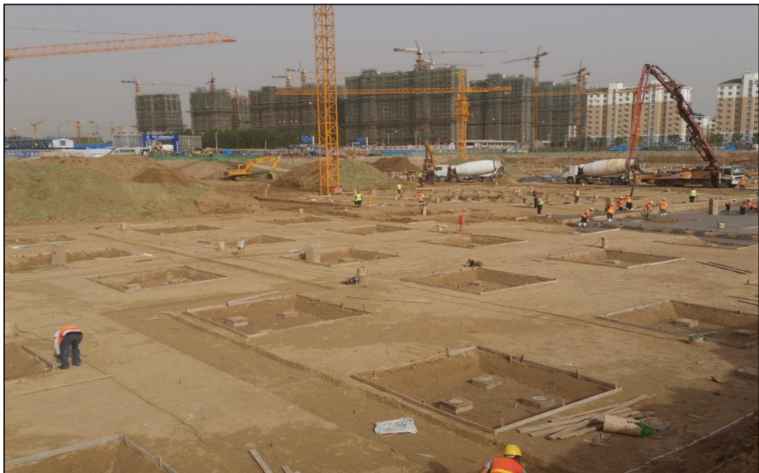
图 4：基坑清槽
