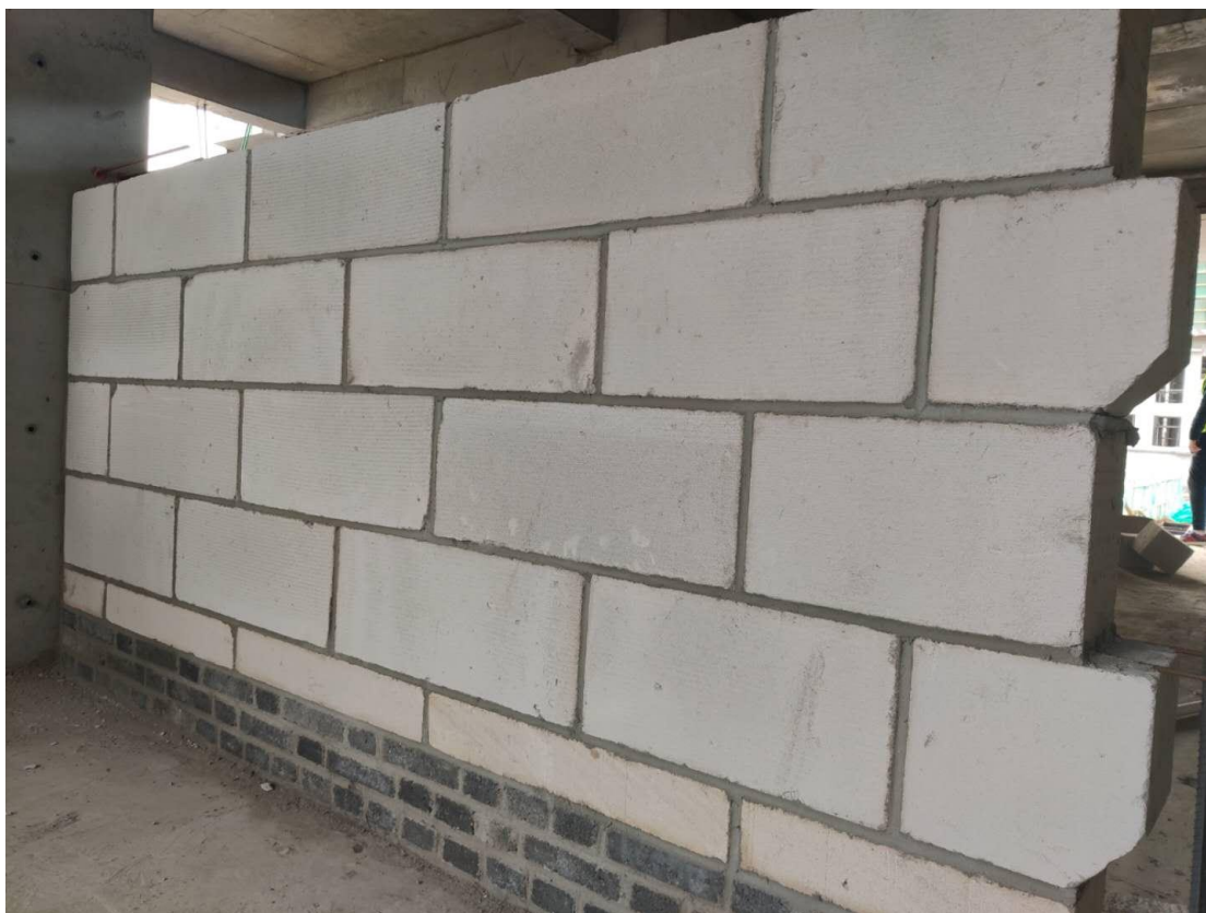
图 21：室内二次结构砌体、导墙
