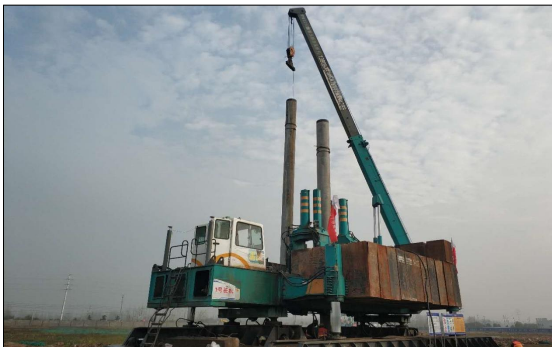
图 2：预制管桩施工
