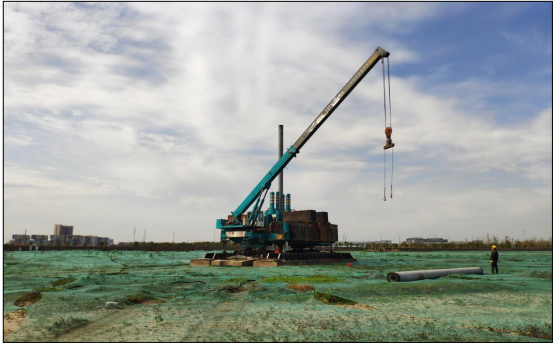
图 3：预制管桩施工
