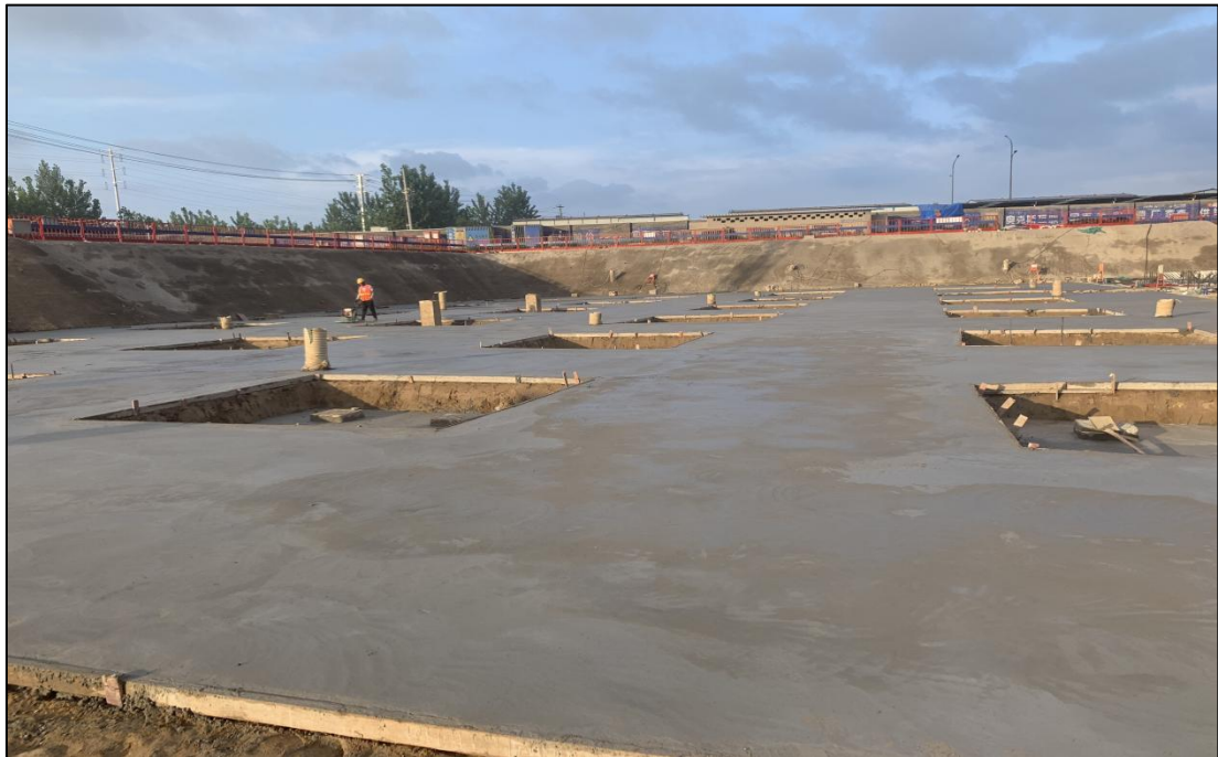
图 6：垫层浇筑
