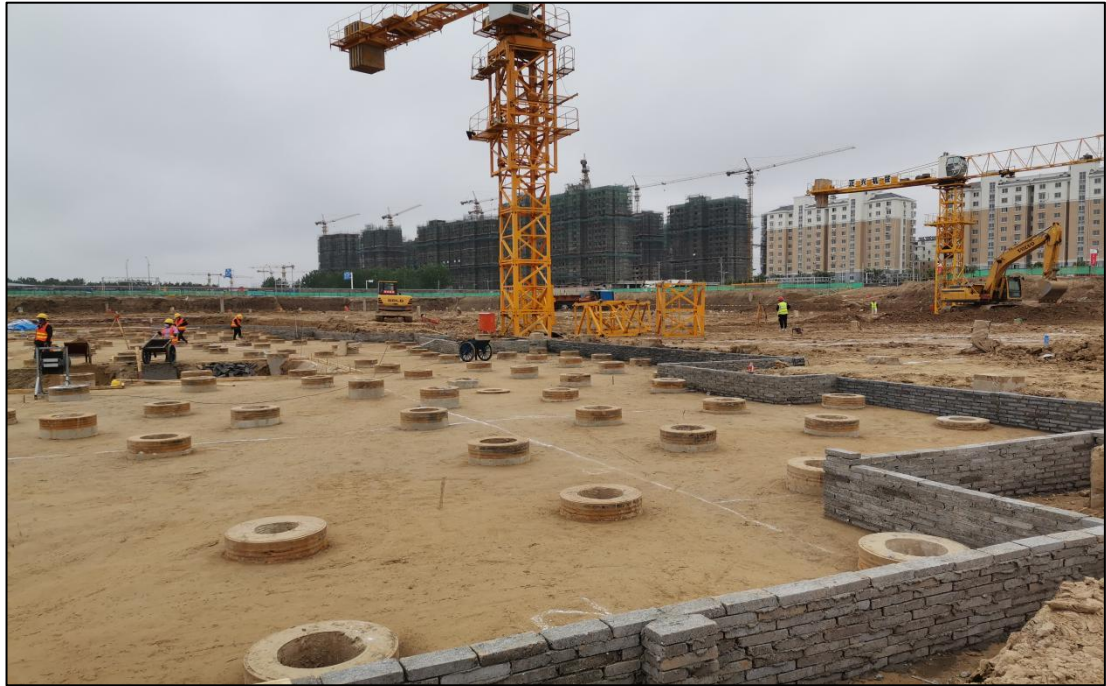
图 5：主楼底板砖胎膜砌筑
