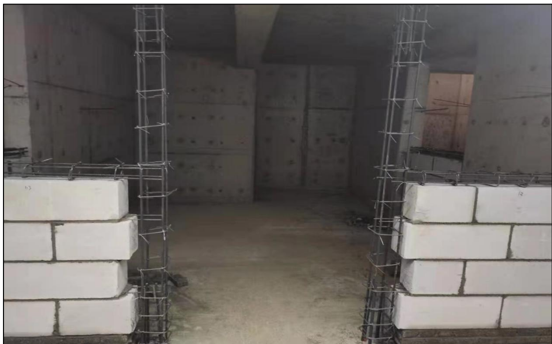
图 20：室内二次结构砌体、构造柱钢筋
