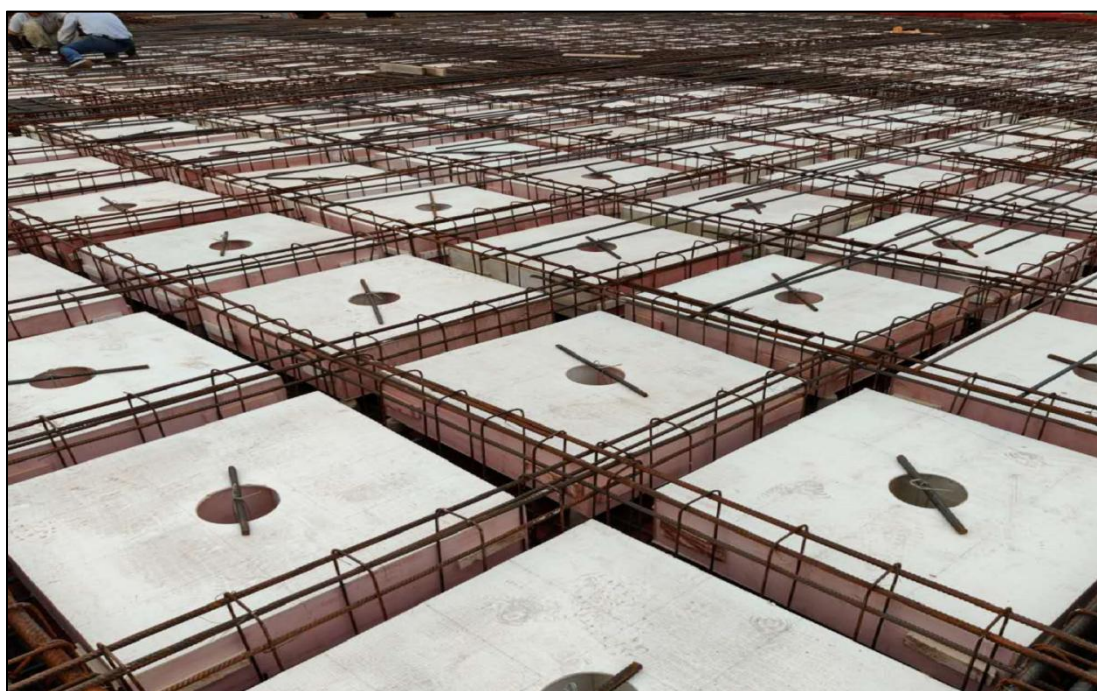
图 14：非人防车库空心顶板模芯安装
