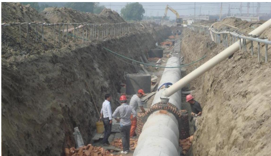
图5-12 类似工程轻型井点降水现场布置图
