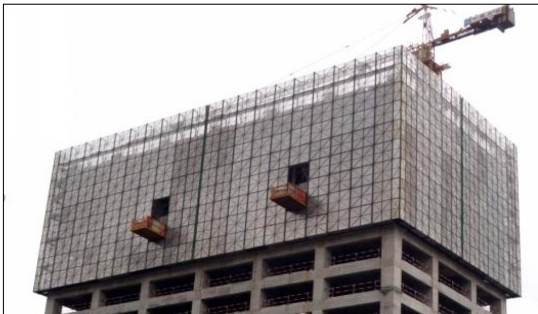
图4-15 集成爬架示意图
