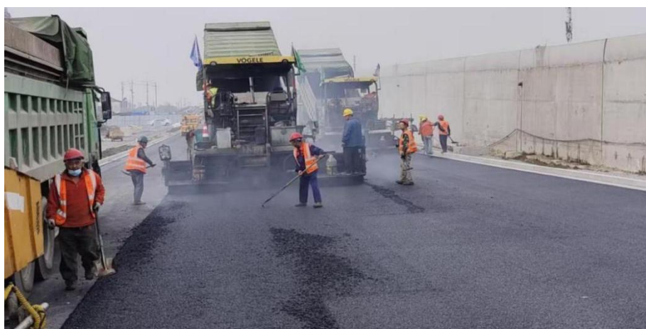
图5-8 类似工程沥青混凝土路面摊铺
