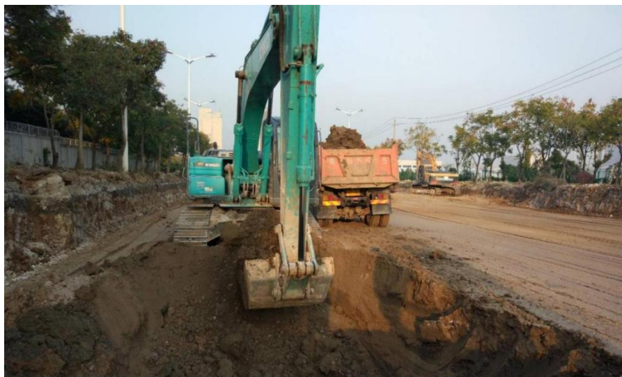
图5-2 类似工程反铲挖掘机挖土装车
