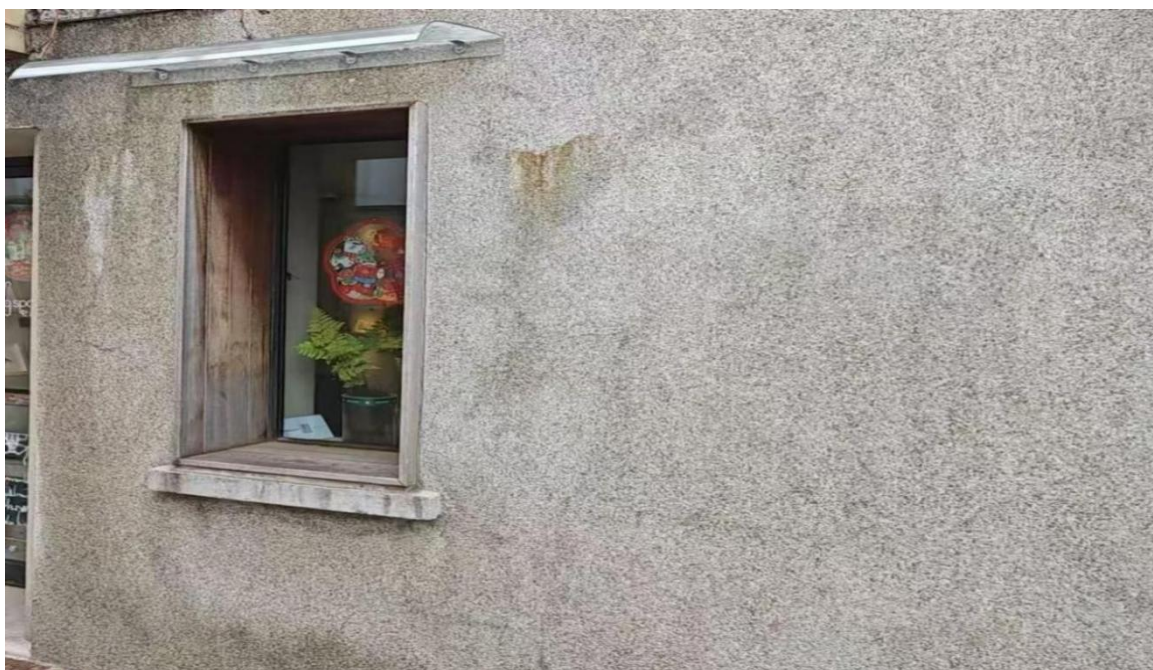
图5-2 民国砂浆外墙面
