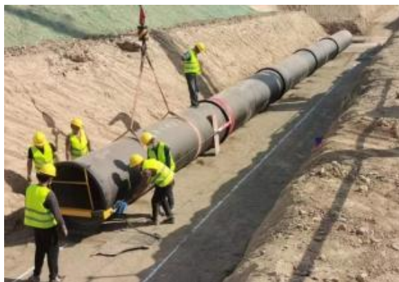
图5-11 类似工程沟槽内球墨铸铁管铺设
